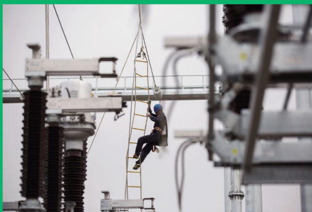
公司员工在对电网升级工程110kV口子变电站进行施工建设
